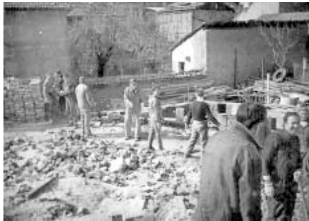
По време на строежа.
